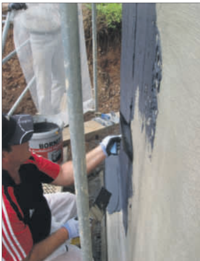
Geht spielend leicht von der Hand: Ein modernes Abdichtungssystem punktet nicht nur mit guter Haftung, es ist auch nach kürzester Zeit wasserdicht, elastisch und beständig. Foto: BORNIT/interPress
